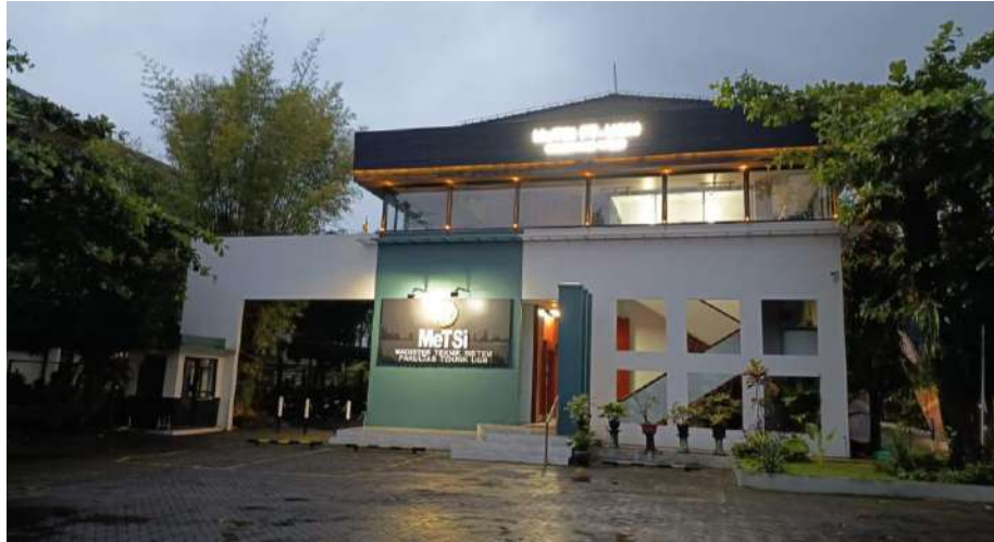
Foto 1. Facade gedung Program Magister Prodi Teknik Sistem
