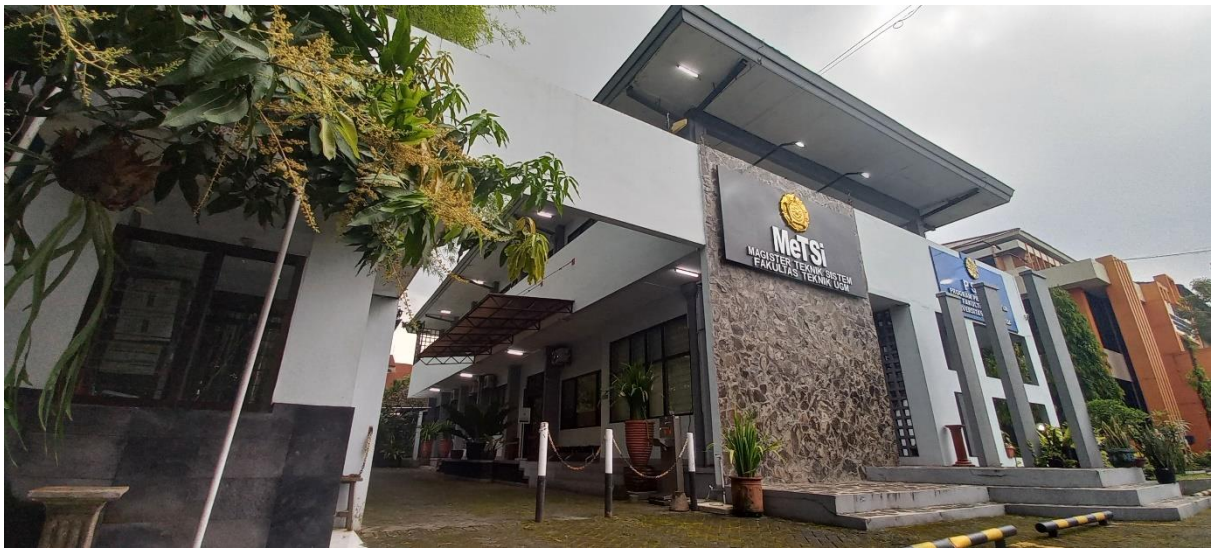
Foto 11. Facade gedung Prodi Teknik Sistem
